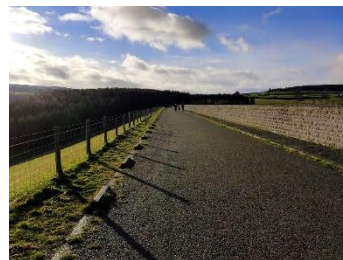
Chemin sur le barrage
