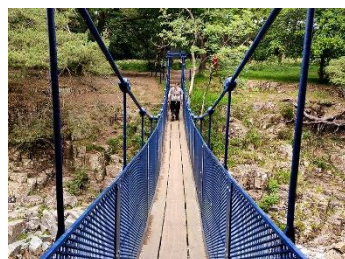
Pont Winch à Low Force
